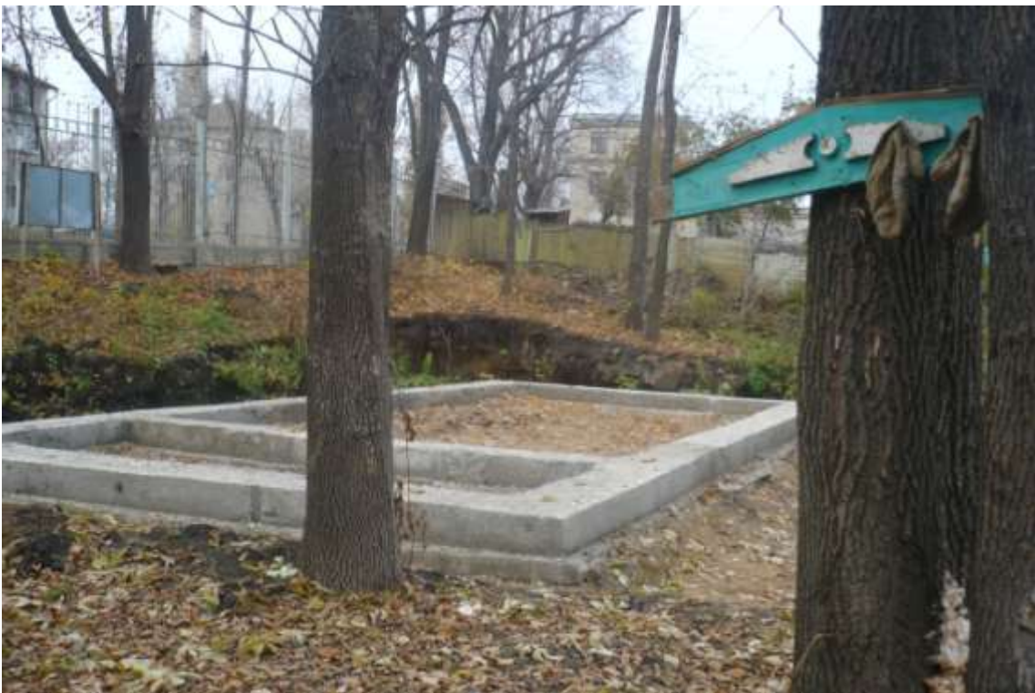
Фото 24. Фундамент в Петровском парке
